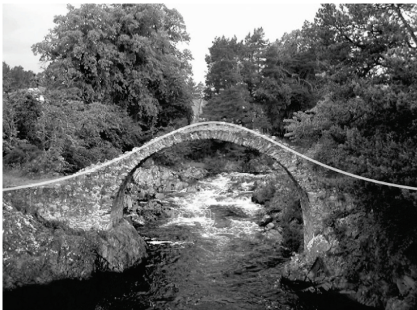
Obr. 7: Soumarský most ve Skotsku (The Old Packhorse Bridge) s grafem funkce podle rovnice (3) (upraveno podle [4])
