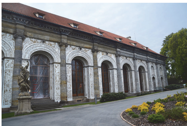
Obr. 4. Fotografie Míčovny (Praha)
